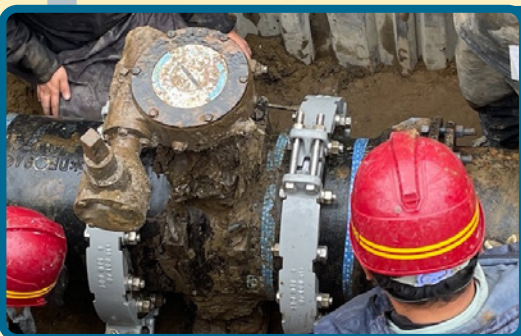
水道管継手の耐震補強
