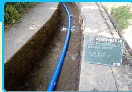
新しい水道管の設置
