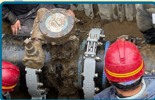
水道管継手の耐震補強
