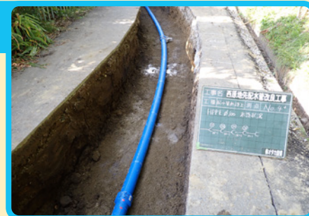
新しい水道管の設置
