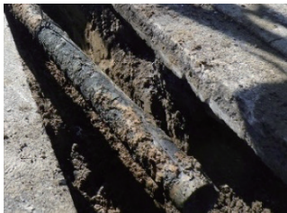
昭和 49 年に布設された水道管（鋳鉄管）
