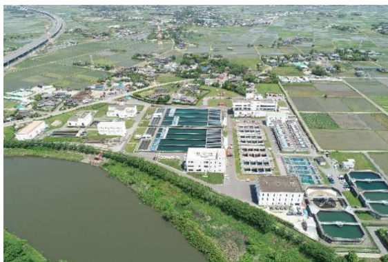
大寺浄水場 (処理能力 135,000 m 3 /日)
