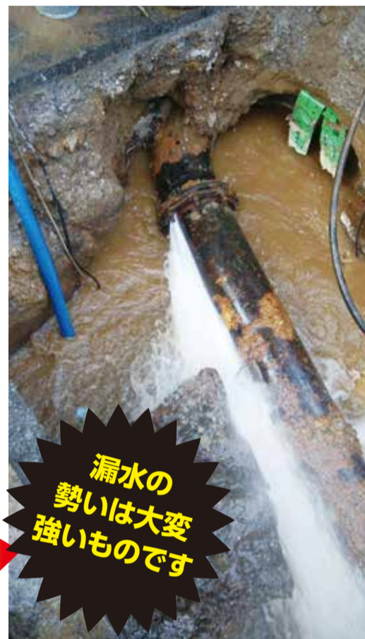
漏水が原因で陥没した道路
