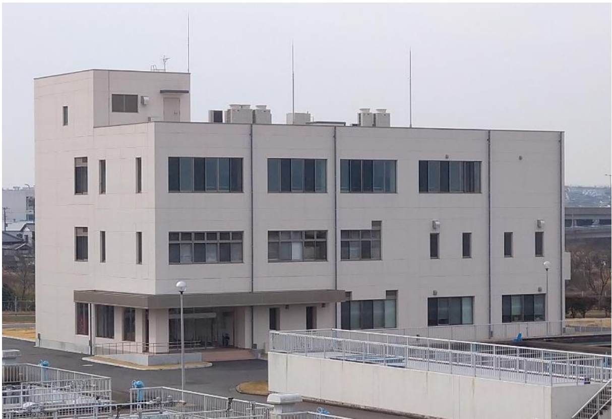
大寺浄水場 新管理本館
