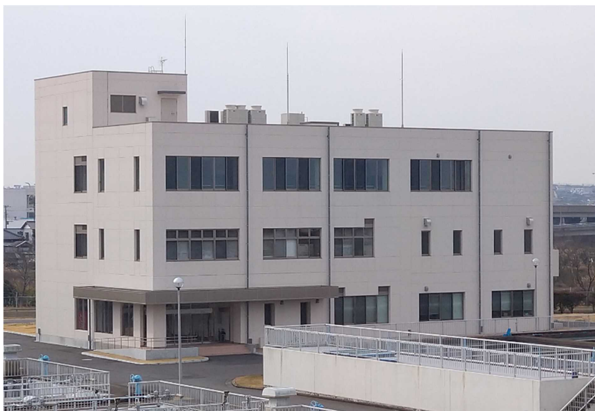
大寺浄水場 新管理本館
