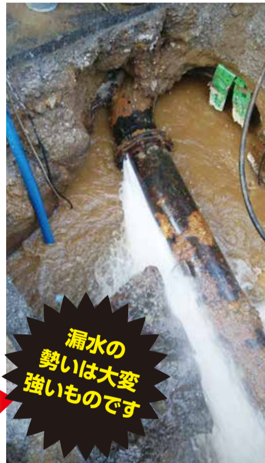
漏水が原因で陥没した道路
