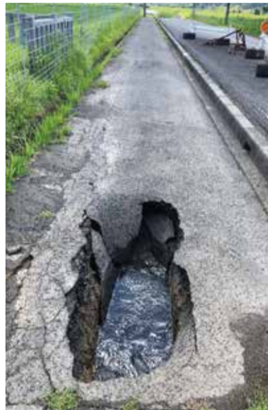
漏水が原因で陥没した道路
