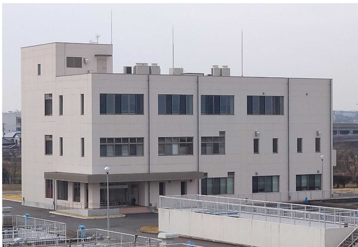
大寺浄水場 新管理本館
