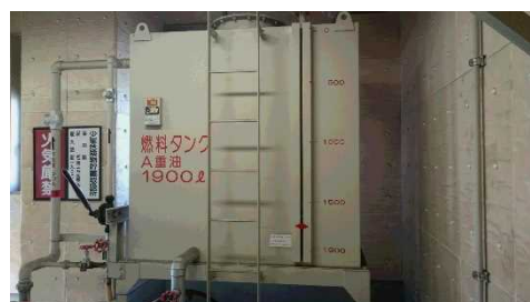
自家発電設備用燃料タンク (本庁舎)
