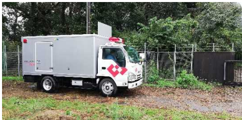
南部調整池 電源車設置
