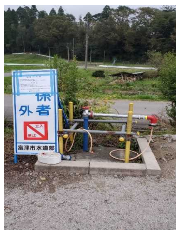
仮設給水栓 (峰上公民館)
