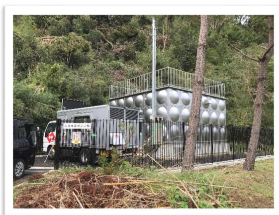
電源車による電力供給状況 (志駒増圧ポンプ場)
