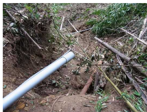
土壌の流失による地下埋設物の露出状況 （丹原送水場送水管路）
