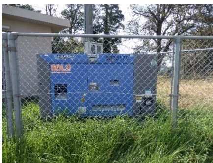
永吉5号井戸 発電機設置
