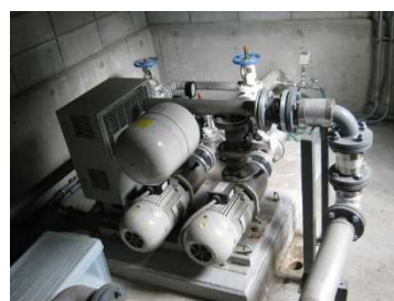
増圧ポンプ設備 (富来田第四加圧所)
