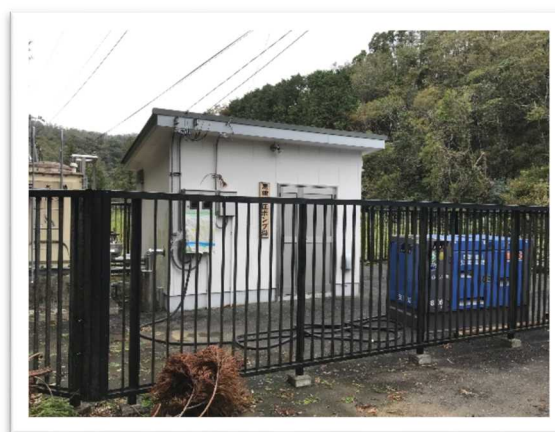
可搬型発電機設置状況 (恩田増圧ポンプ場)
