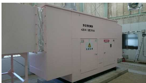
ディーゼル式自家発電設備 (上烏田浄水場)
