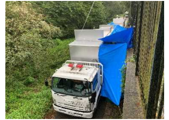
第2中継ポンプ場 電源車設置
