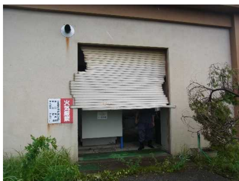
自家発電室シャッター破損状況 （中台浄水場）
