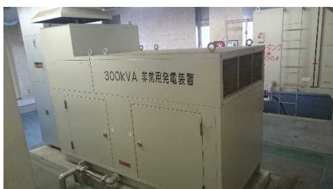
ガスタービン式自家発電設備 (本庁舎)
