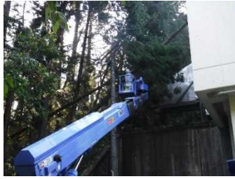
第2中継ポンプ場 PAS 復旧
