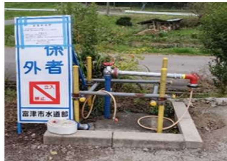
仮設給水栓設置
