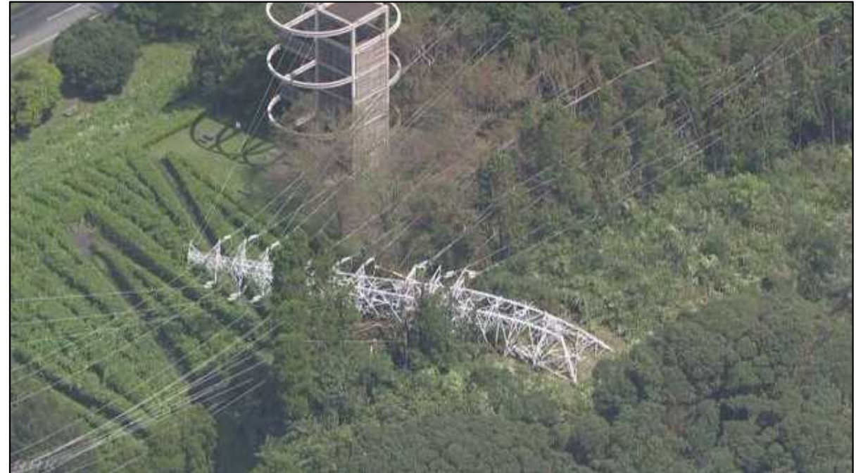
君津市長石 東京電力送電線鉄塔倒壊
