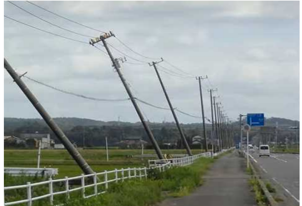
袖ヶ浦市内 電柱倒壊
